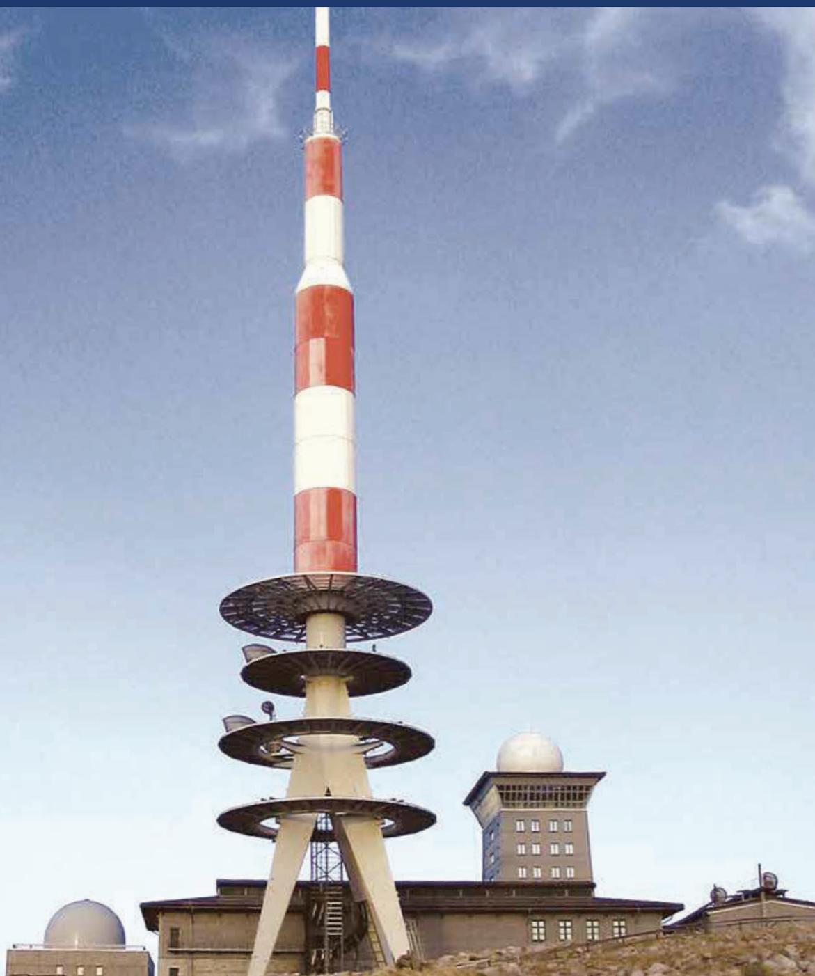
Schlanke Strukturen, wie hier zum Beispiel die Antennenanlage Brocken, können durch Wind zu starken Querschwingungen angeregt werden, die das gesamte Bauwerk gefährden. Abhilfe schaffen RINGFEDER® Schwingungsdämpfer oder -tilger, welche zusammen mit einer pendelnd aufgehängten Masse sicher unter allen Temperaturbedingungen Schornsteine oder Antennen schützen.
