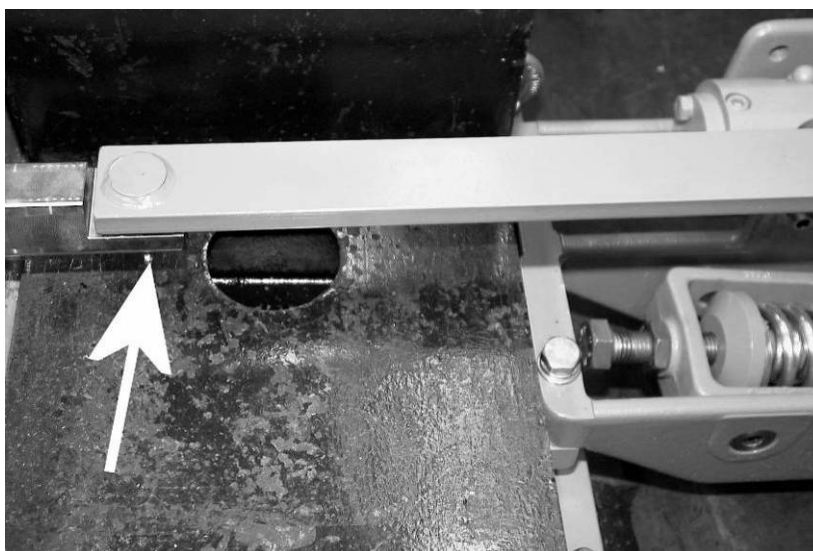
Rys. 72: Zabezpieczanie cięgien napędowych
