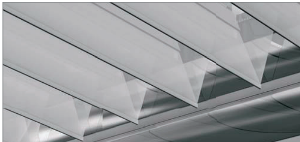
průsvitný materiál s dvojitým švem
