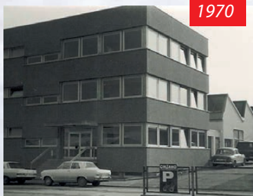
Administrativní budova, Bietigheim-Bissingen
