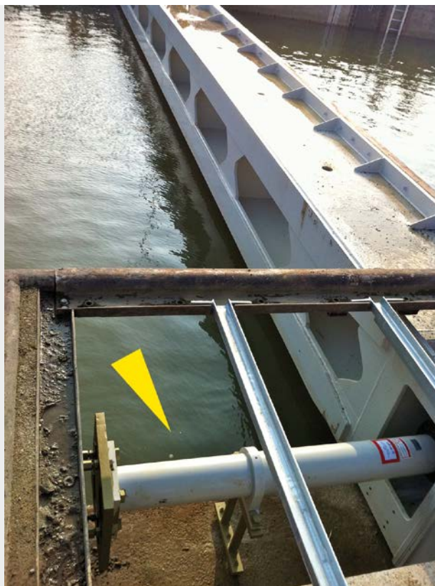
Les amortisseurs de sécurité haute résistance, spécifiquement conçus pour cette application, ont la capacité de freiner dans les écluses des poids atteignant quatre millions de kilogrammes Mourik Limburg BV, 6101 AJ Echt, Pays-Bas
